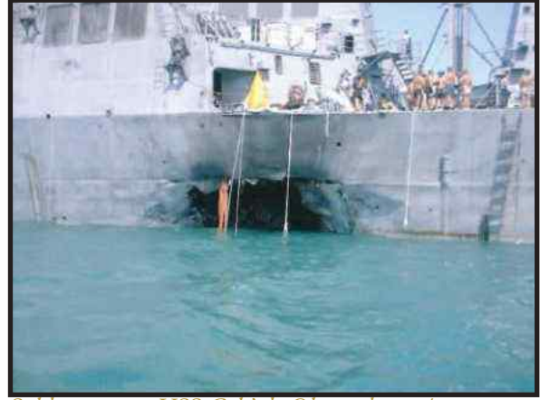
Saldırı sonucu USS Cole'de Oluşan hasar / Damage of USS Cole after the Attack
